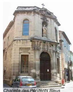
Chapelle des Pénitents Bleus Edifices religieux
