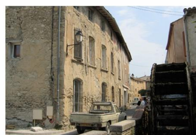
Façade de fabrique
