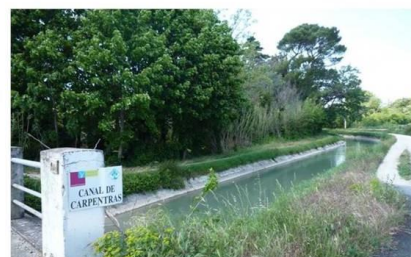
Le canal de Carpentras à la cote NGF 100 mètres
