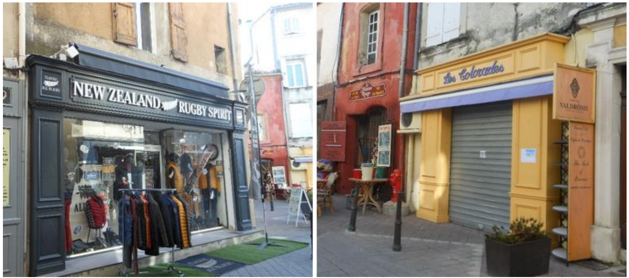
Des enseignes en lettres découpées fixés directement sur la façade
